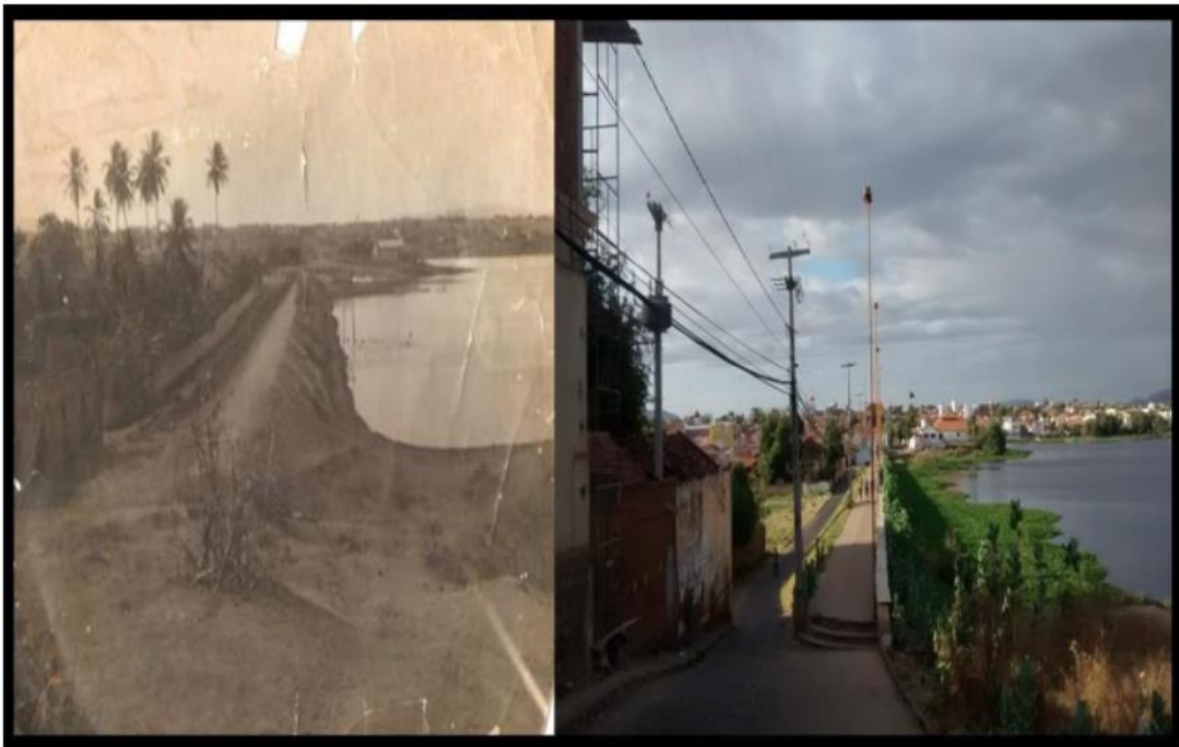
Figura 5: Parede do Açude Grande no período de construção entre (1913-1917)
