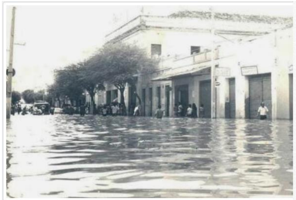
Figura 13: Inundação de 1974, Avenida Dom José
