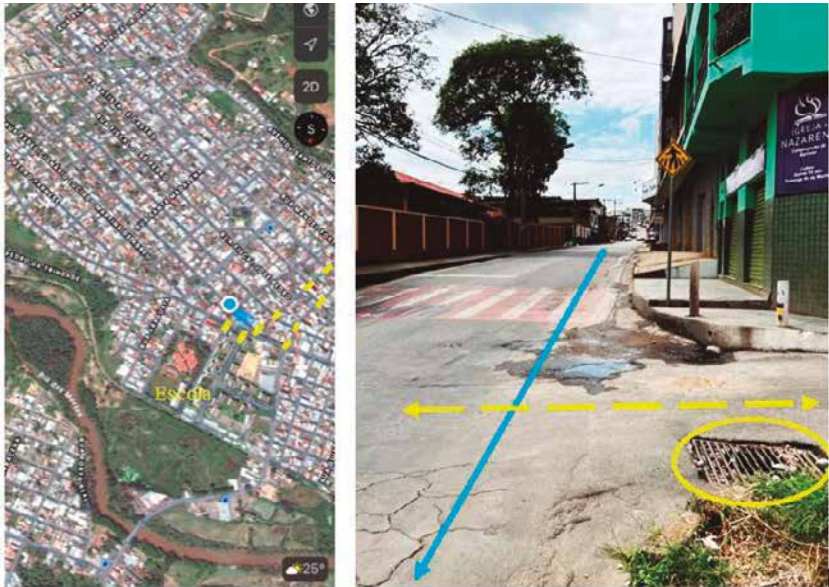
Figura 8: a) Indicação dos bueiros (em amarelo nas ruas transversais às ruas que ligam o fundo do vale ao topo do relevo, ou seja, liga a área comercial e de serviços à área onde predominam moradias no alto do morro; b) detalhe do cruzamento de ruas, com destaque para o bueiro na rua transversal à rua longitudinal topo/vale.
